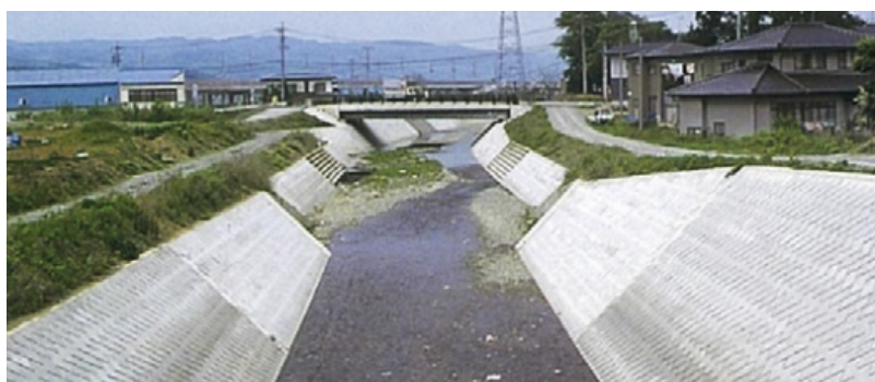
河川改修工事後
