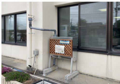
安曇野町舎の設置事例
