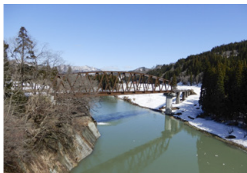
(2) 復旧後の第7只見川橋りょう
