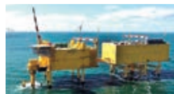
社会インフラ (当社が参画するドイツ海底送電事業の洋上変電所)
